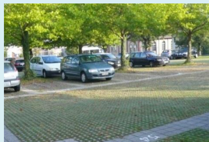
Stationnement en dalles alvéolées enherbées
