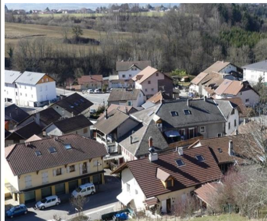
Les toitures de Basse Bonne
