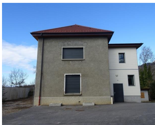
L'école de musique façade Sud avec son extension récente
