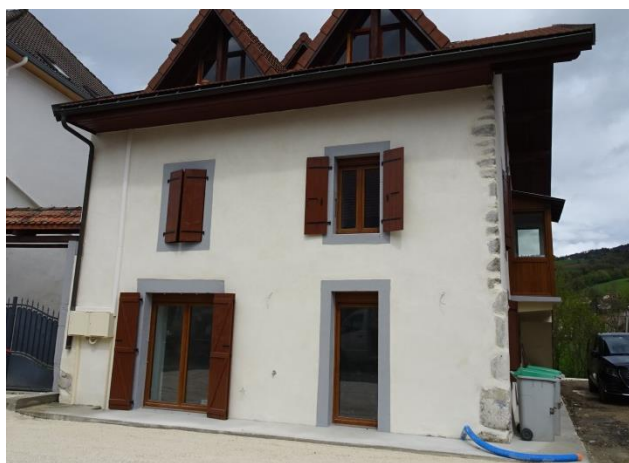
Mur enduit couvrant clair, encadrements redessinés avec une teinte plus foncée. L'enduit arrive en mourant sur les pierres de la chaîne d'angle. Haute Bonne
