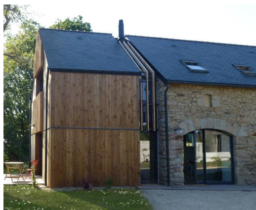
Extension d'une ancienne ferme réhabilitée La Ferm'h à Baden (56), Architectes ADAO Architecture (35) & Gérard Lucas (56),
