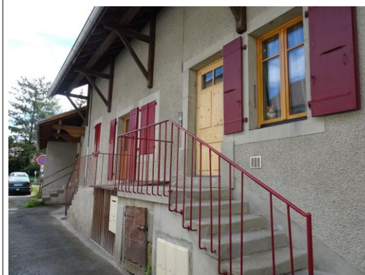
Escaliers extérieurs R du Bief-74_p765-764-763_
