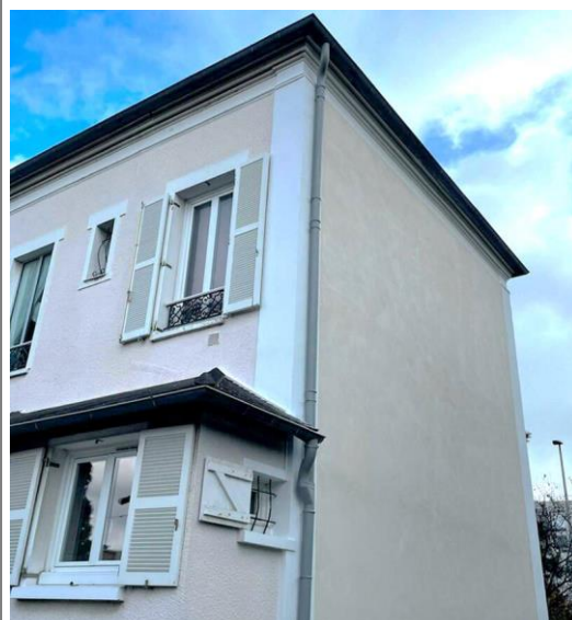
Façade rénoverée avec un enduit isolant chaux-liège ©DSD Rénov
