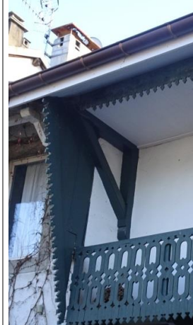
Lambrequins, consoles ouvragées
