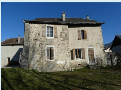
Haute-Bonne - Herbe jusqu'au pied des murs du bâti
