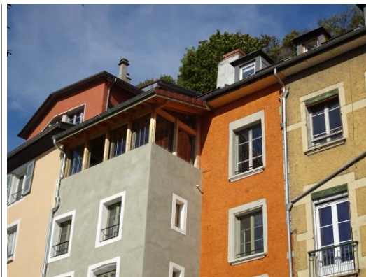
Surélévation traitée comme un couronnement, en structure bois et métal, vitrée sur toute la longueur. La toiture a été reconstruite, identique. Grenoble (38) E. Martin-Hernandez archi. Grenoble 38
