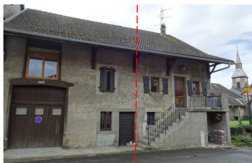
R Haute Bonne-209_p484_ ouvertures d'habitation à droite, ouvertures agricoles à gauche.
