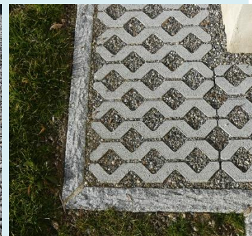
Alvéoles béton avec graviers Haute-Bonne place de l'église
