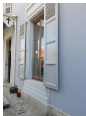
OUI- enduit isolant remplaçant l'enduit existant Il permet de respecter le décor existant (modénature)
