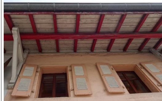
Passées de toit des anciennes fermes, reposant sur des consoles – Basse Bonne
