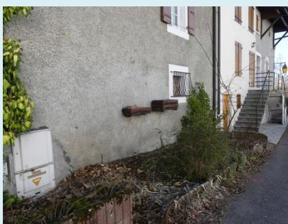
Haute-Bonne - Végétation en pied de mur
