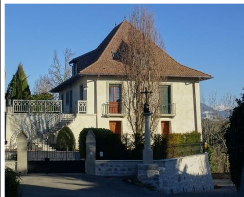
Toitures à 4 pans, coyau en bas de pente maison de maître
