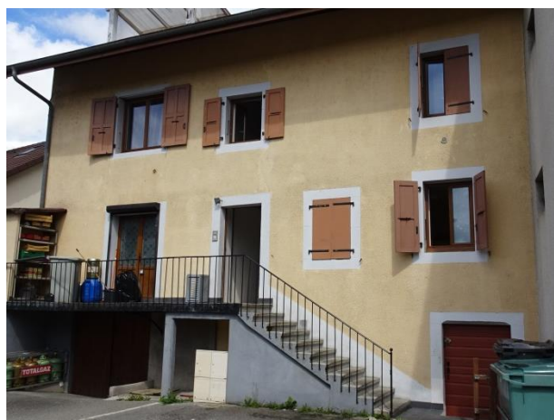
Mur enduit couvrant teinté, encadrements redessinés avec une teinte blanc cassé. Basse Bonne
