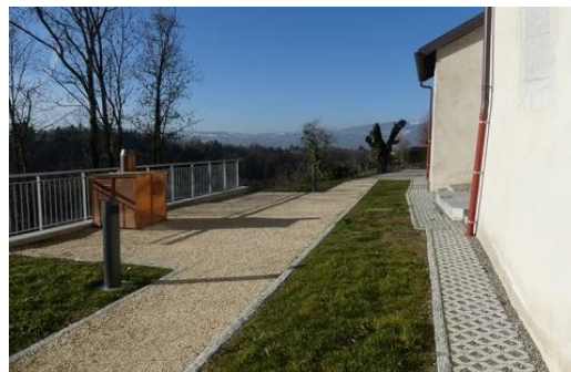
Aménagement des abords de l'église (Haute-Bonne)
