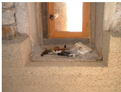
Mur en moellons de pierre avec «correction du rayonnement froid» par un enduit intérieur chaux chanvre
