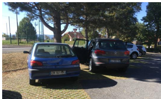
Stationnements perméables de la mairie de Bonne
