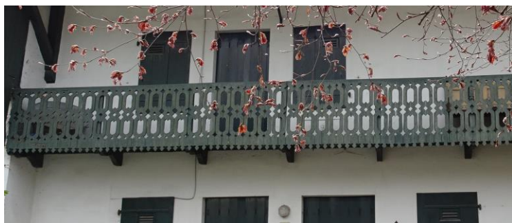
Garde-corps en bois à conserver, R Haute Bonne-319_p2391
