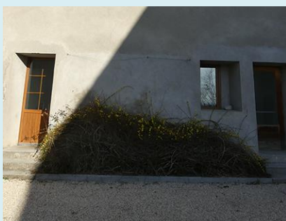
Haute-Bonne - Végétation en pied de mur
