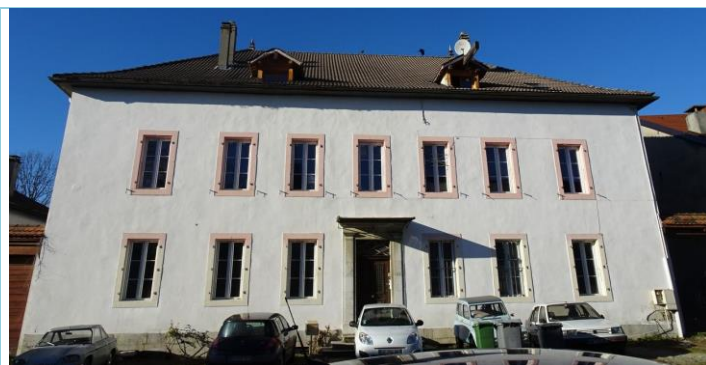
Cette maison gagnerait à retrouver ses volets ! Rue de Haute-Bonne - 264_p3811
