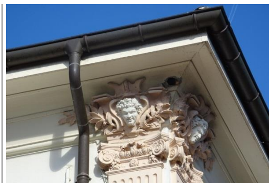
Passées de toit des maisons de maître, ici coffrées, planches larges et couvre-joints Haute Bonne
