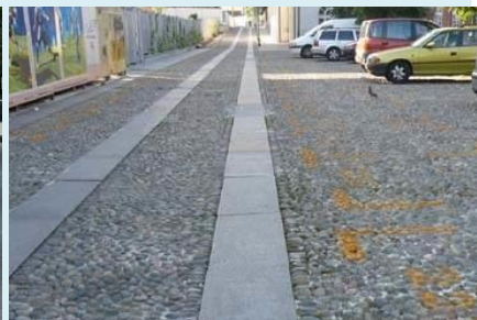
Calade pour l'ensemble de la rue et dalles de granit pour les bandes de roulement (Turin, Italie)
