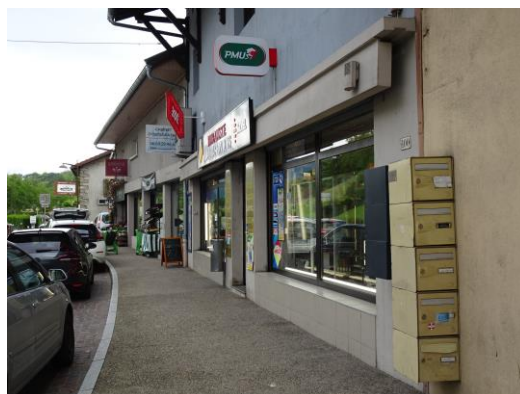
Basse Bonne séquence urbaine protégée. En cas de reconstruction (ces bâtiments ne sont pas protégés) il faudra s'implanter à l'alignement.
