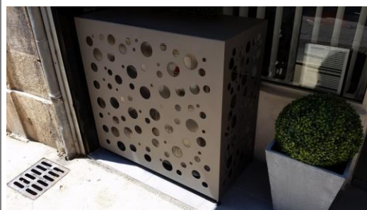
Climatiseur posé au sol, et dissimulé derrière un caisson
