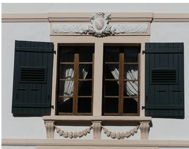
Les menuiseries de Haute Bonne ne sont pas très anciennes mais ont été refaites avec soin
