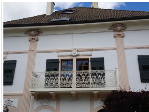
Balcon en pierre, garde-corps en serrurerie R Haute Bonne-328_p3629_
