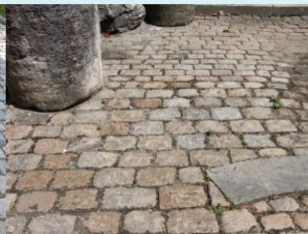
Pavés non jointoyés
