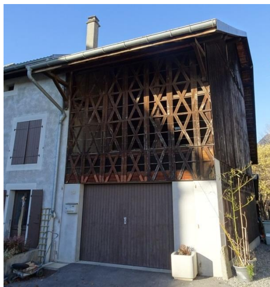
Bâtiment antérieur à 1948, Haute Bonne Caractéristiques des granges et des parties dépendances des anciennes fermes (hangar, granges, séchage des récoltes...) Ce sont des structures bois recouvertes d'un bardage bois plein ou ajouré. Celui-ci a une mise en œuvre savante : c'était l'ancien séchoir à draps de la maternité voisine, aménagé dans une ancienne grange.
