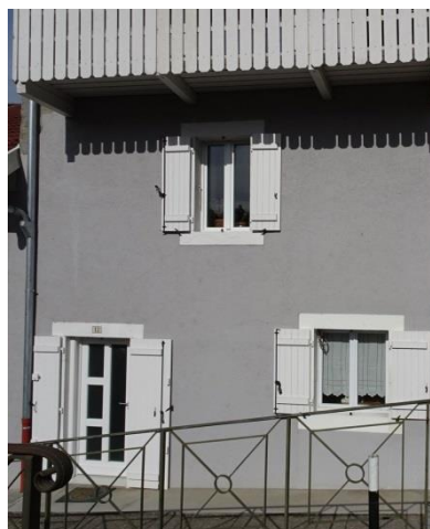
Basse Bonne Fenêtres en PVC. Les montants sont plus épais, accentués par le blanc pur
