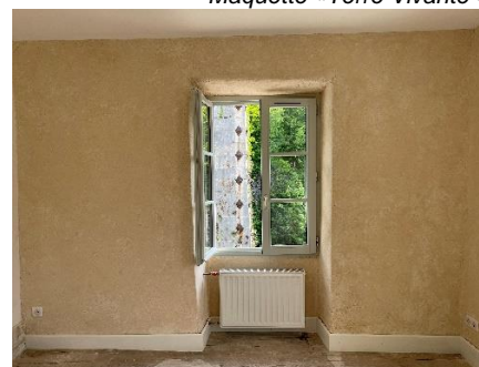
Parement avec finition enduit chaux lissé
