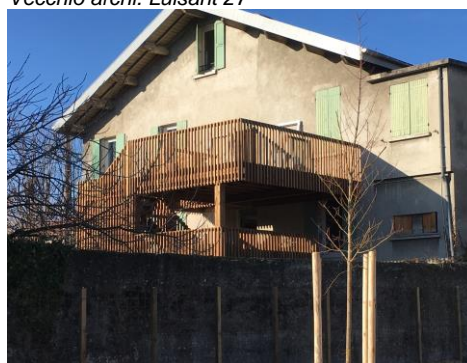
Extension en façade arrière. Bourg-lès-Valence 26
