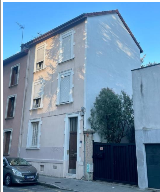
Pignon isolé avec du liège, Grenoble
