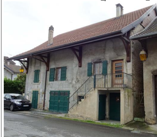
Escaliers extérieurs R Hte Bonne-197_p483_maison de vigneron_
