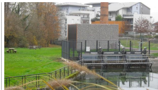
micro-centrale de Cran-Gevrier, sur le Thiou
